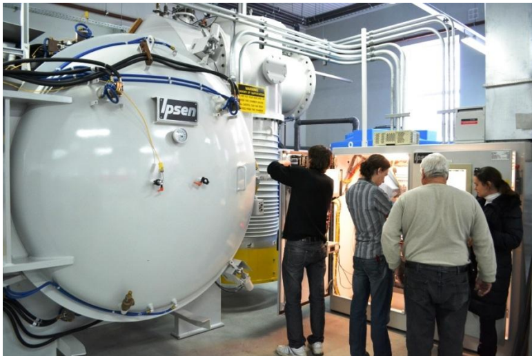
Пуско-наладочные работы вакуумной печи IPSEN
